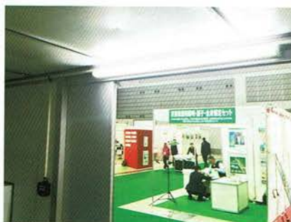
▲ソーラーパネルによる屋内照明
