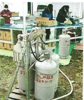
▲プロパンガスを使用した燃料システム。
